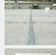
床下には、電気ピット(電気・インターネット回線等)、機械ピット(ガス・上下水道)が交互に組み込まれている。
