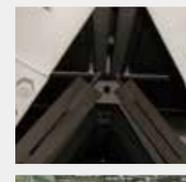
ガセットプレート (吊点は540ヶ所/ホール、東西南北約3m間隔、制限荷重450kg / ヶ所)
